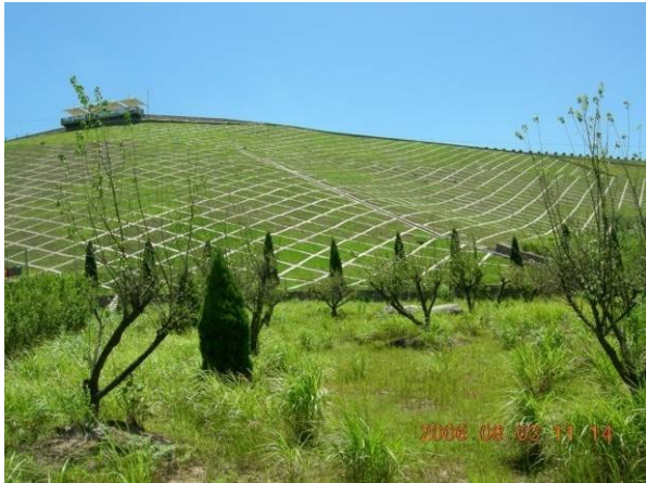
北副坝后坡框格植草
