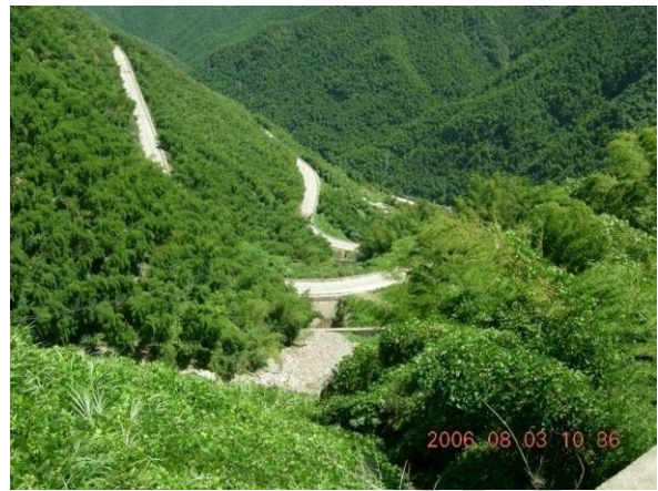
连接公路边坡植被恢复措施
