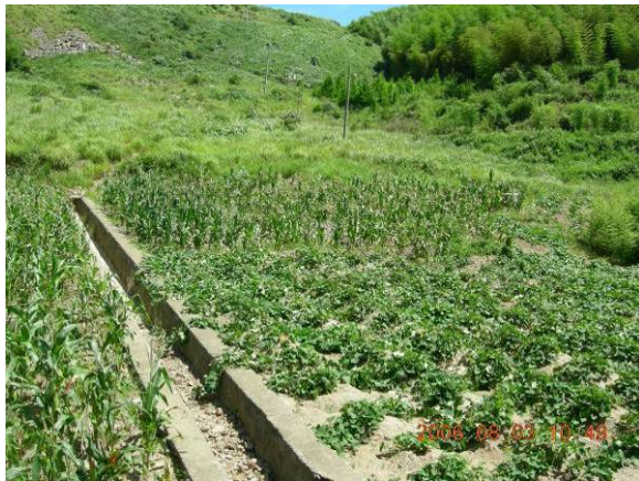
潘家岭弃渣场植被恢复措施
