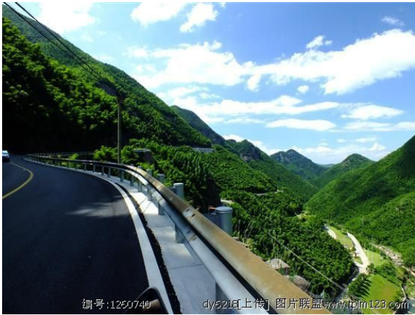
上下水库连接公路
