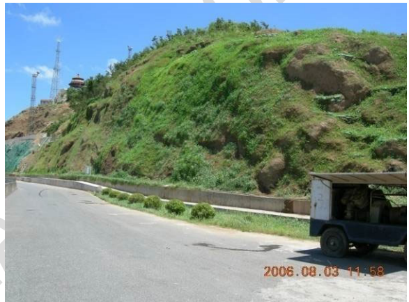
上水库开挖边坡生态护坡
